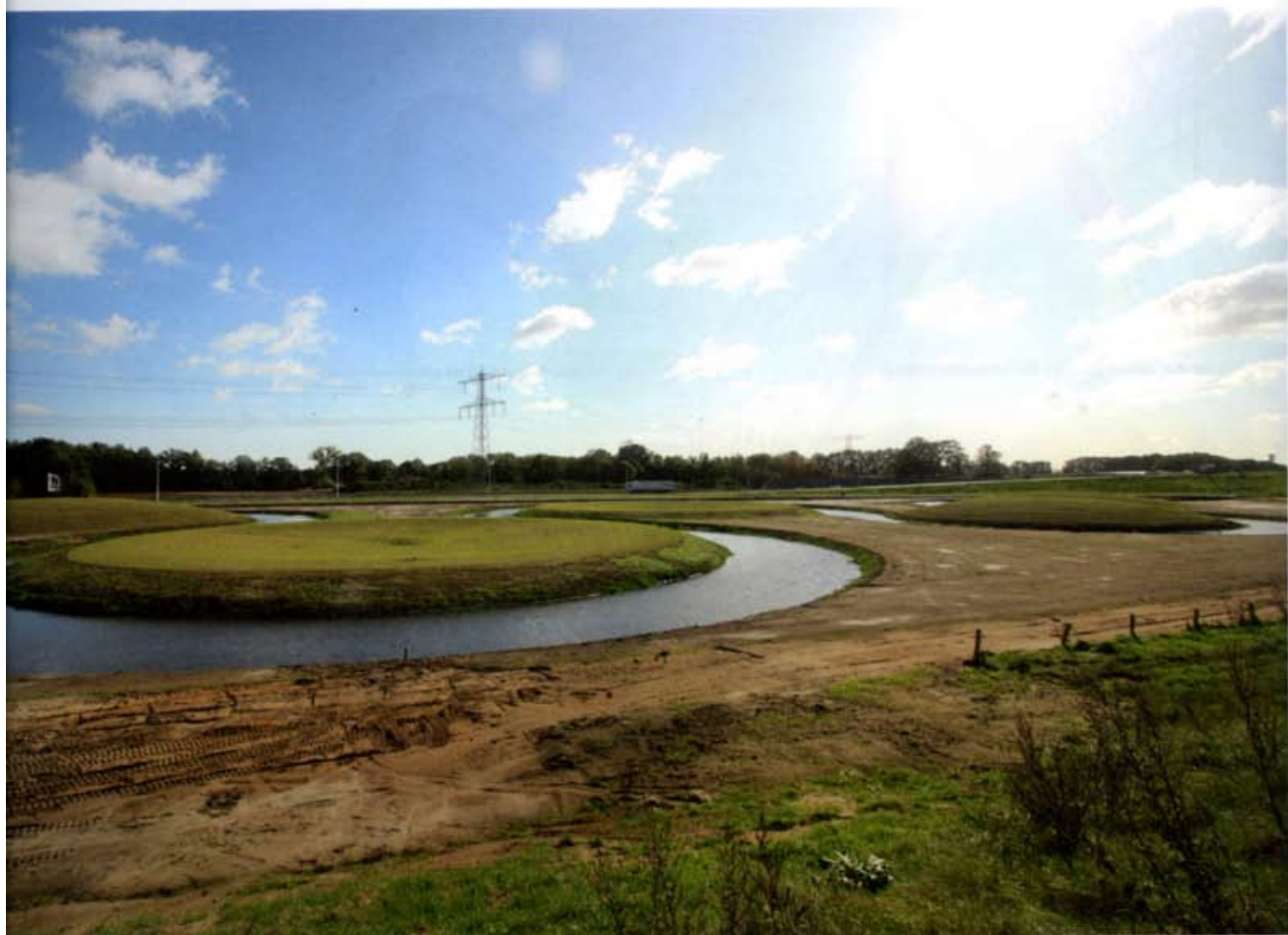
Het waterblad gezien naar het zuidoosten.
